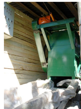
Figura 5.1: Central Micro-Hidráulica de Teno
