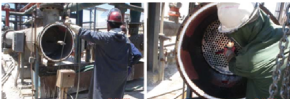
Imagen No 1: Para operaciones de contacto directo con ácido, se debe utilizar equipo antiácido completo.
