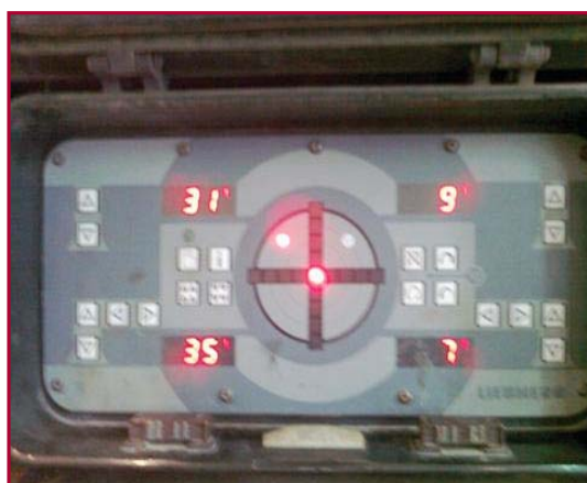
Lectura de la presión de los estabilizadores sobre el terreno
