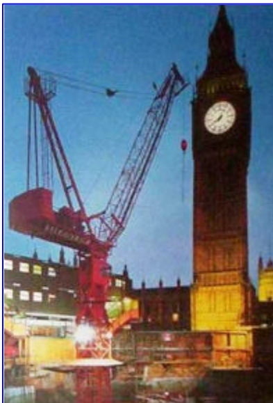
Grúa Torre Pluma Abatible Big-Ben. Londres, Inglaterra.
