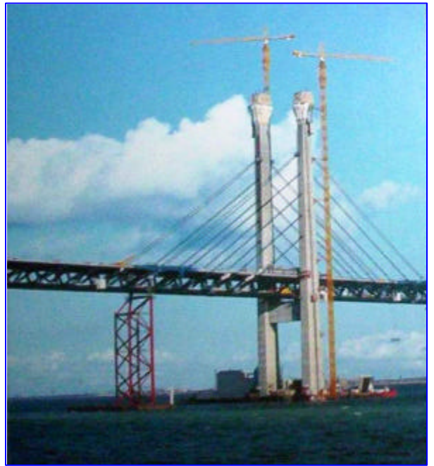
Grúas Torres Trepadoras, Construcción puente. Dinamarca.
