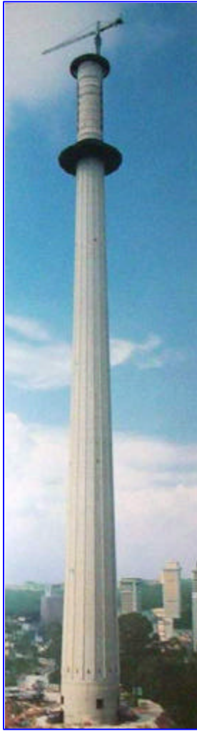
Grúa Torre Pluma Horizontal, Torre TV. Kuala Lumpur. Malasia.
