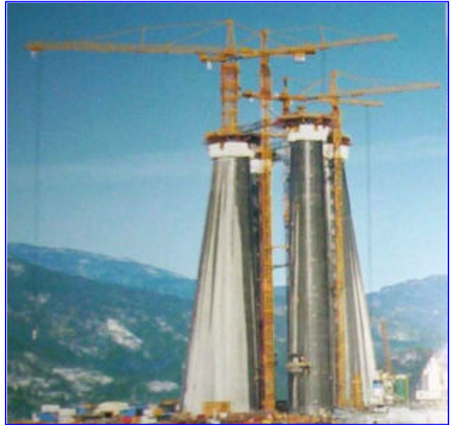
Grúas Torres Pluma Horizontal, Plataforma petrolera. Noruega
