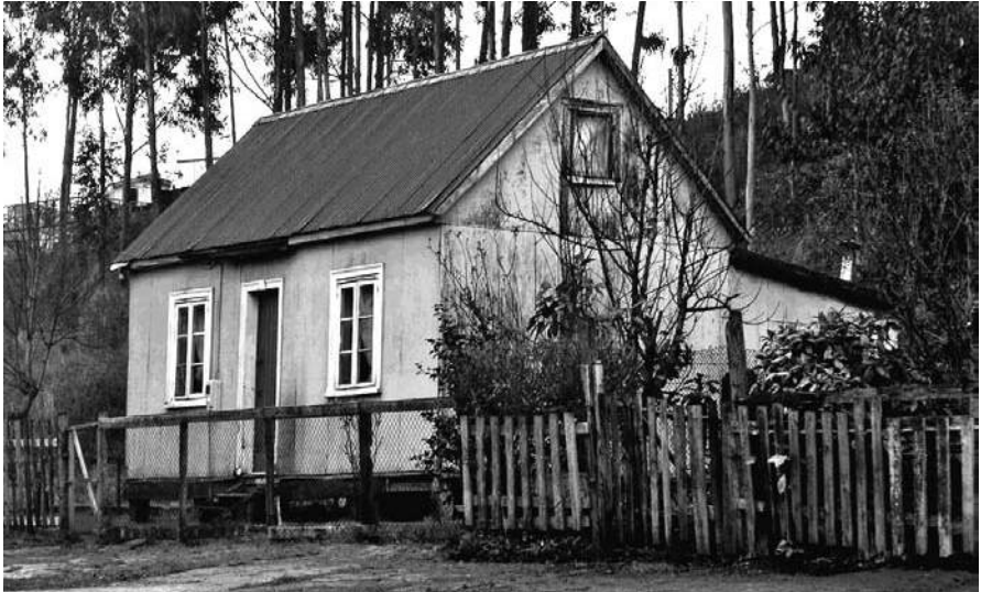
Figura N° 4 Vivienda obrera del molino Collico
