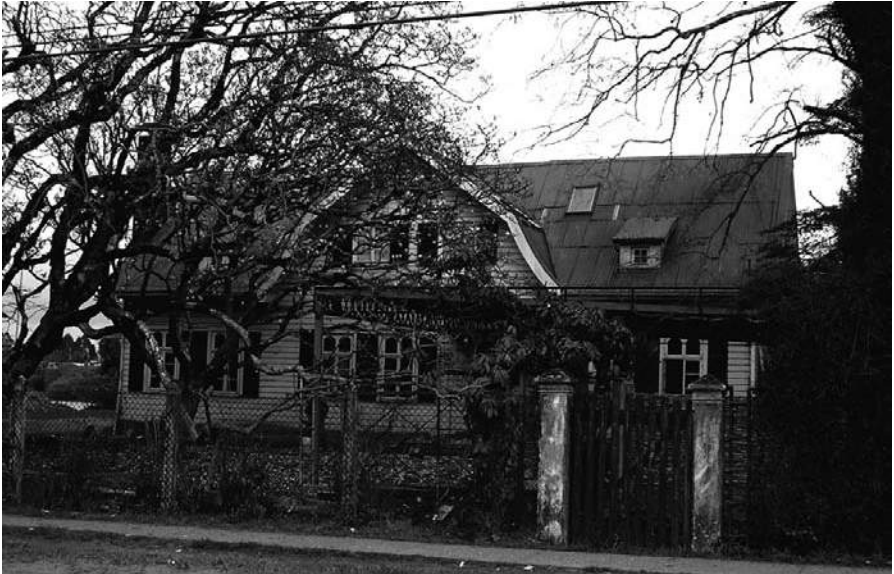
Figura N° 7 Vivienda restaurada en Collico
