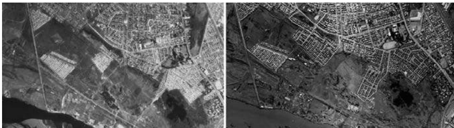
Figura N° 13 Hualpén Sur. Crecimiento laberíntico por agregación de barrios-jardín. Años 1992 (izquierda) y 2002 (derecha)
