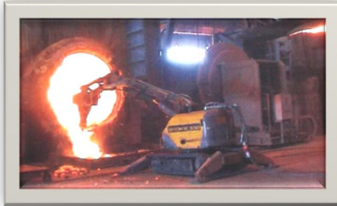
Fotografía 3: Hornos de cubilote.
