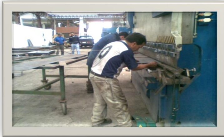
Fotografía 13: Doblado de planchas de acero.
